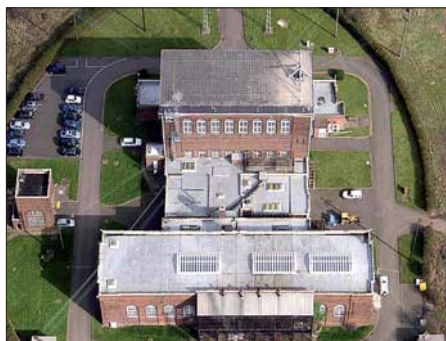
Das bisherige MSF-VLF-Sendegebäude (oben) sowie die Generatoren-Halle (unten)
